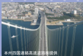
本州四国連絡高速道路提供
